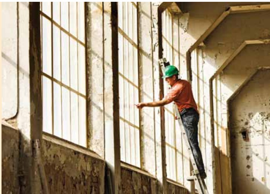
De ruim honderd jaar oude gietijzeren ramen en betonnen dakconstructie blijven
